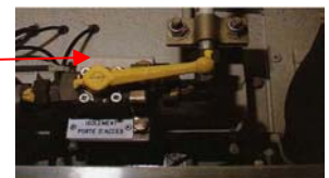
Hahn hinter Deckenpaneelen
