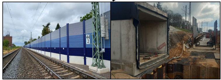
Schallschutzwand > 800m: Baufortschritt EÜ (F) Sonsfeld
