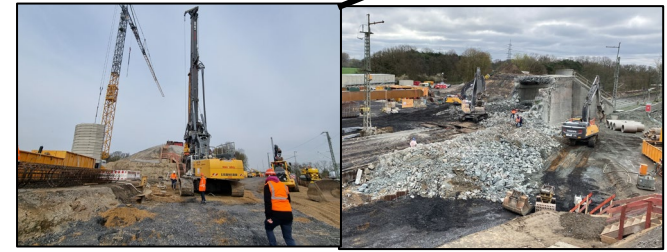
SÜ Willy-Brandt-Str. – Abbruch, Bohrpfähle, OLA-Zusammenhang
