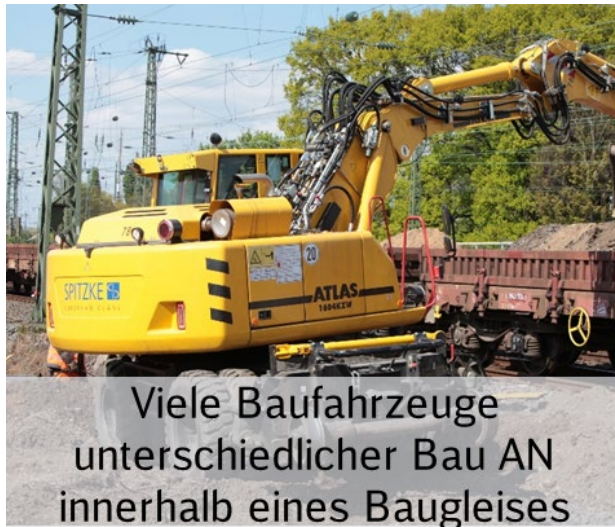
Mehrere Bau AN innerhalb einer Sperrpause im Gleisbereich
